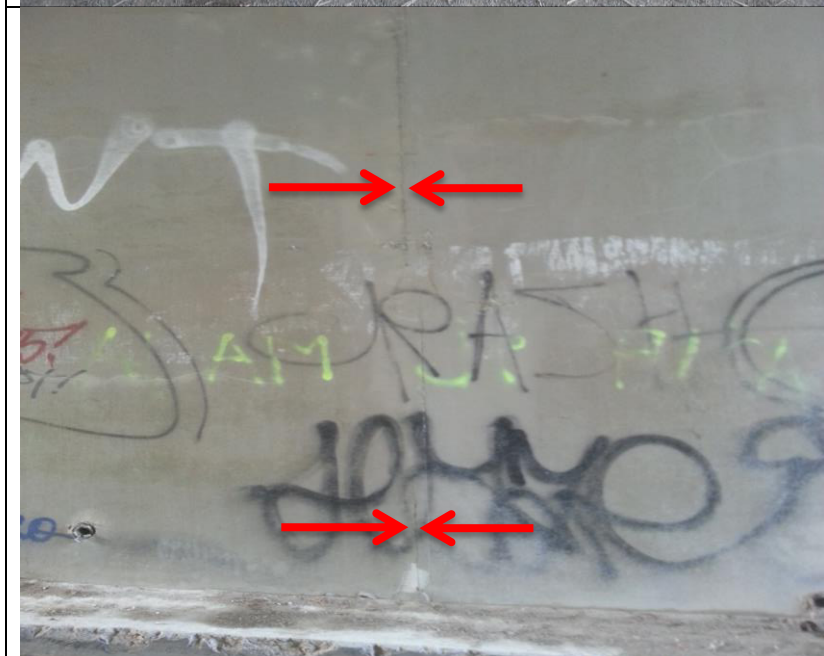
Obrázek 6: Most km 131,236 (brněnská opěra) • patrná dilatační spára procházející přes klenbu do dřívku břeclovské opěry
