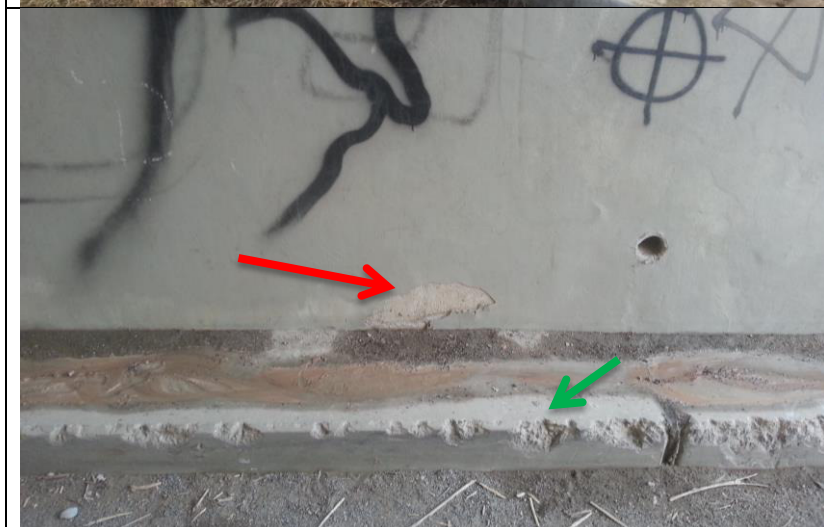
Obrázek 5: Most km 131,236 (brněnská opěra) • odpadlá povrchová úprava ve spodní části dřívku (červeně) • otlučená hrana betonového soklu (zeleně)
