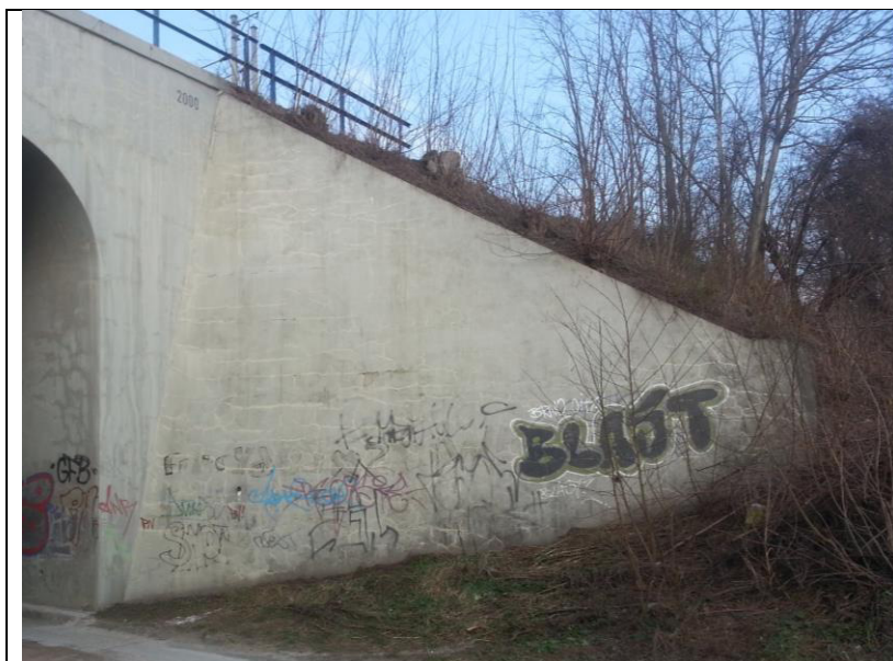
Obrázek 16 Most km 131,236 (brněnská opěra - pravé křídlo) • prosvítající staré praskliny pod povrchovou úpravou
